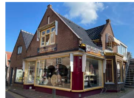
Een aantal fraaie gevels zou baat kunnen hebben bij het verwijderen van enkele niet oorspronkelijke elementen, zoals in dit geval de later aangebrachte omkasting van (inmiddels niet meer aanwezige) zonwering of de reclame borden voor de oude dakgoot. De onverzadigde kleuren lijken wel goed te passen bij het pand.
