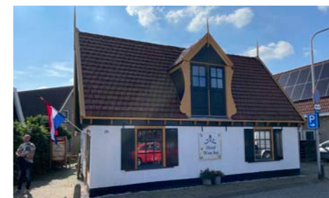
Deze dakkapel en enkele andere details zijn niet origineel maar van recente datum. Het geeft het langsdak wel direct een gezicht naar de straat en doorbreekt de horizontale orientatie van de gevel.
