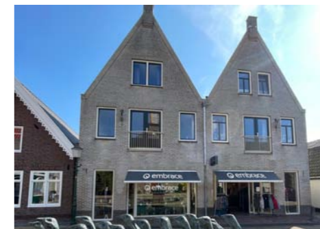
Hoewel als 1 pand ontwikkeld is een duidelijke opsplitsing in de beleving van de gevel gemaakt. De winkel beslaat het hele pand zonder een brede plint los te knippen van de bovenbouw. (in dit beeld is de breedte van de luifels terug gebracht naar de breedte van de pui, in werkelijkheid zijn de luifels iets breder)
