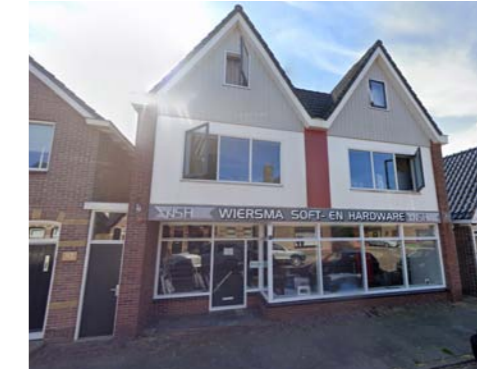
Gevelbrede reclame borden brengen een knip aan tussen plint en gevel 1e verdieping
