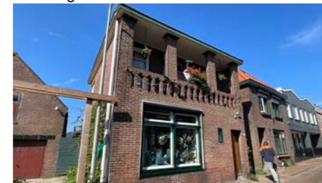
Bijzondere gemetselde gevel
