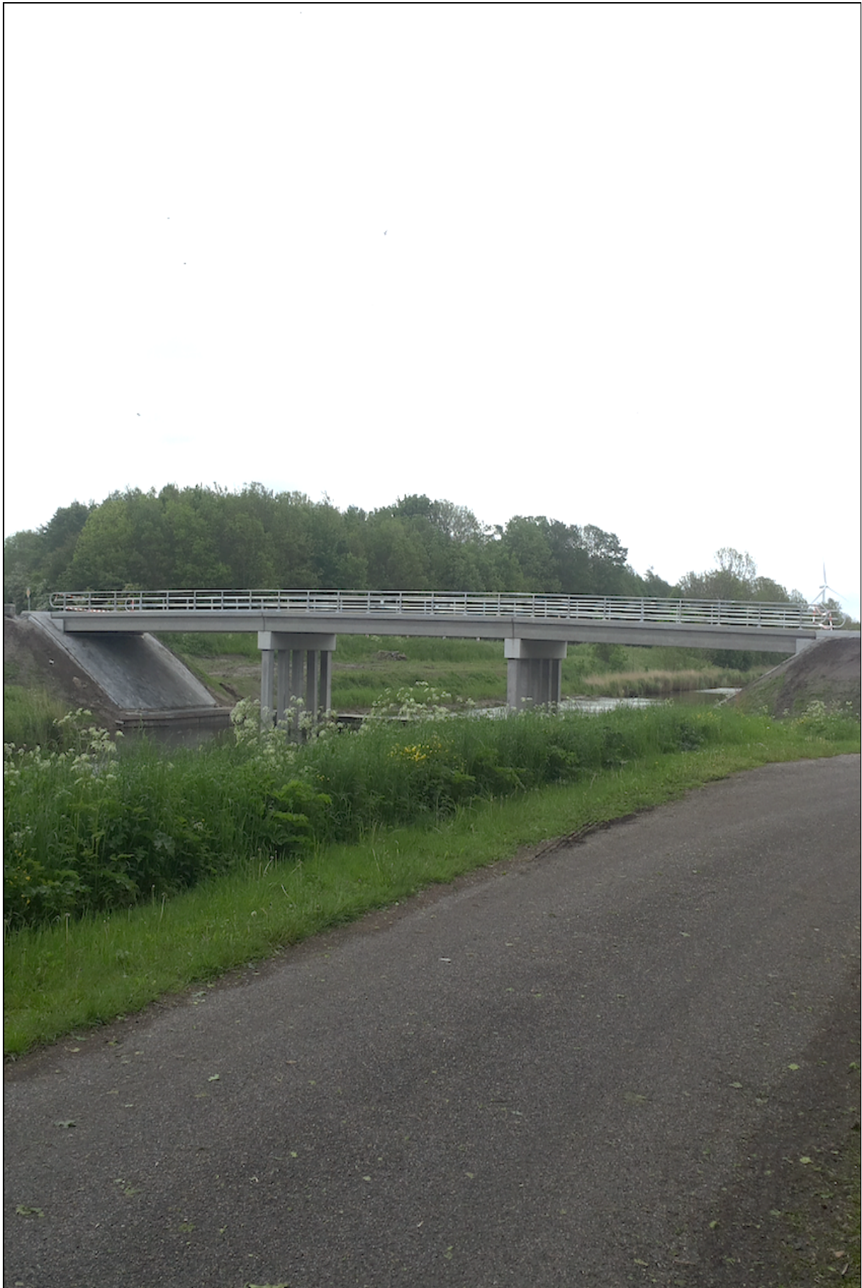
Foto: Nieuwe brug over de Flevoweg
