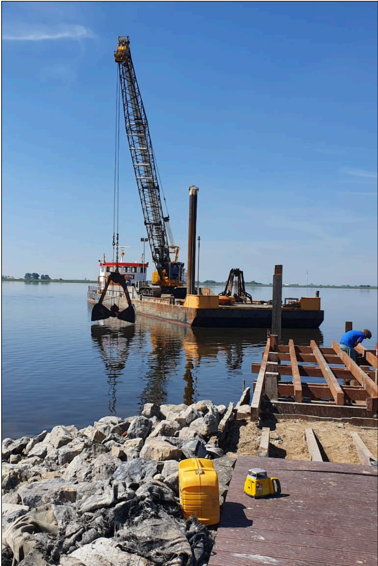
Aanleg van een nieuwe steiger bij het Lutjestrand
