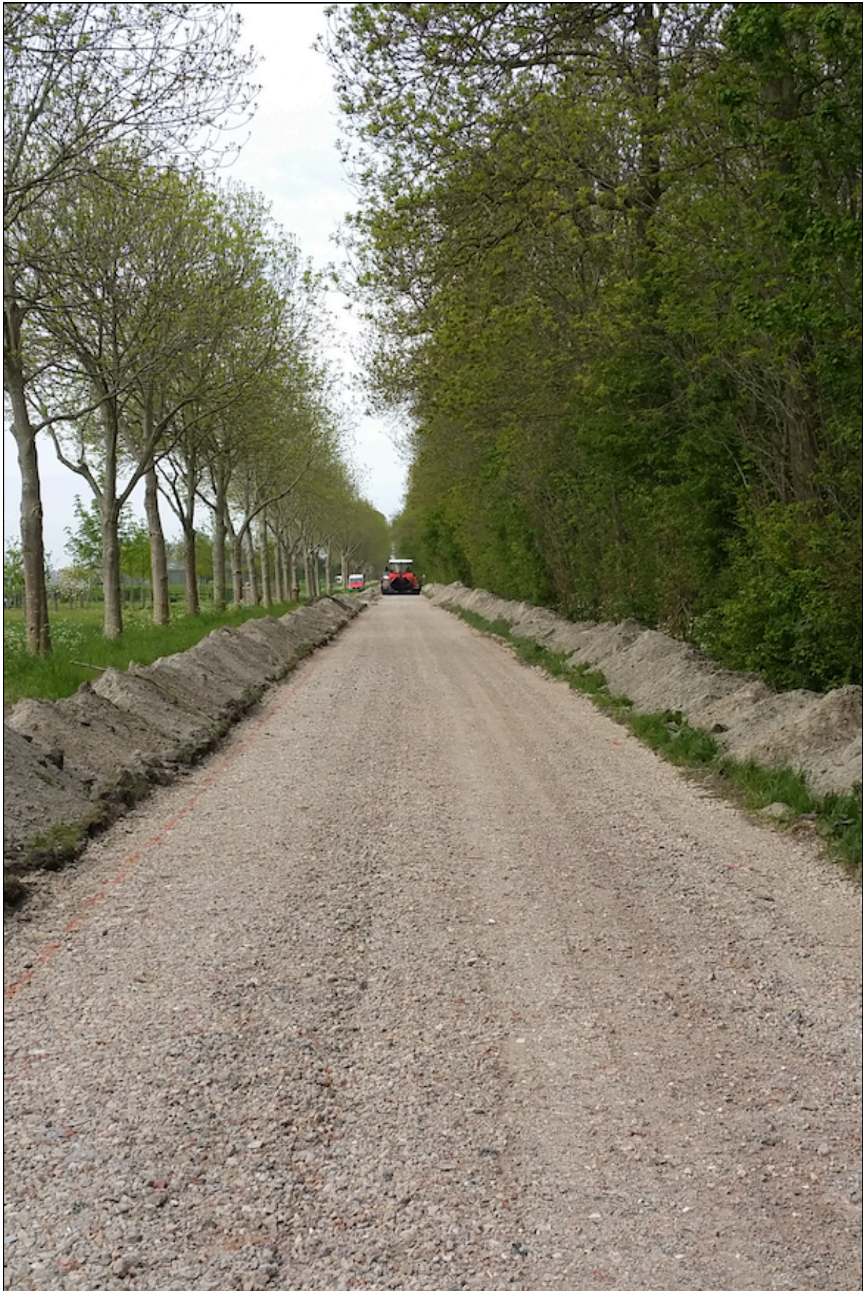
Werk aan de weg (groot onderhoud asfalt Kolhornerweg)
