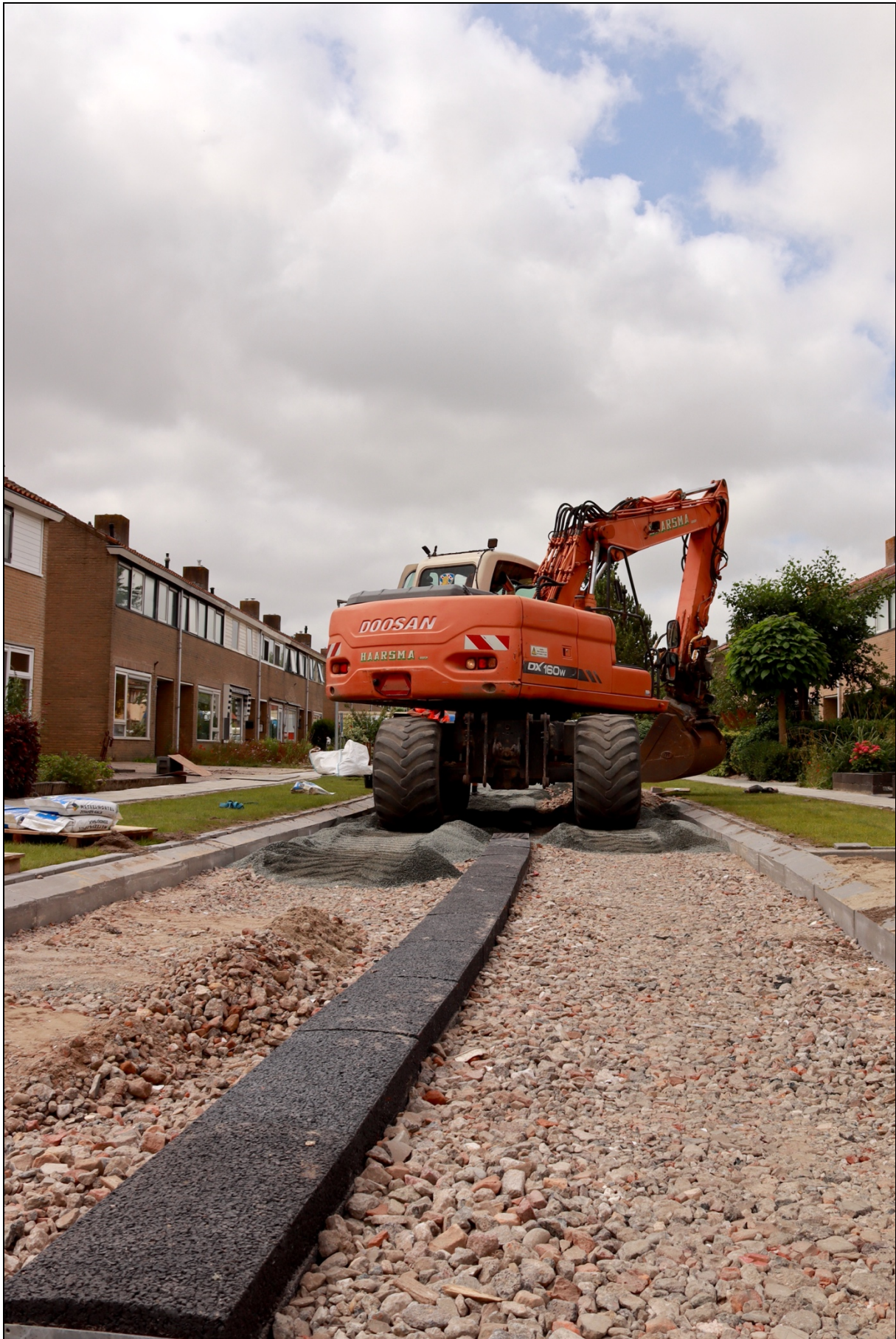
Aanleg waterdoorlatende goot (Permeoblok) in Wieringerwerf
