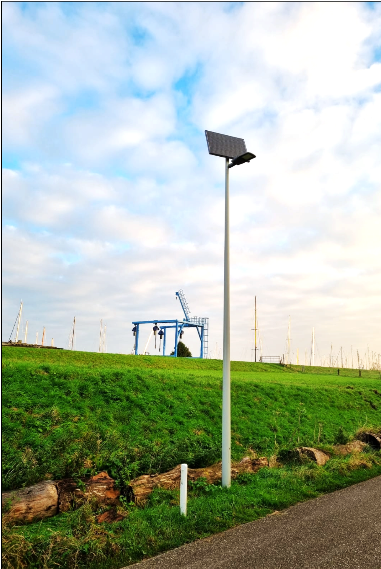
Nieuwe lichtmast op zonne-energie langs de Noorderdijkweg bij Den Oever
