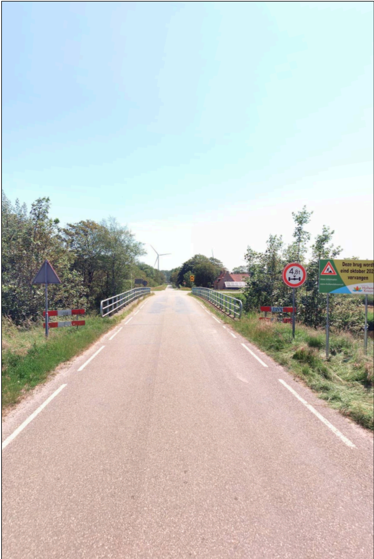
Te vervangen vaste verkeersbrug Hippolytushoeverweg (bron: Cyclomedia Technology B.V.)
