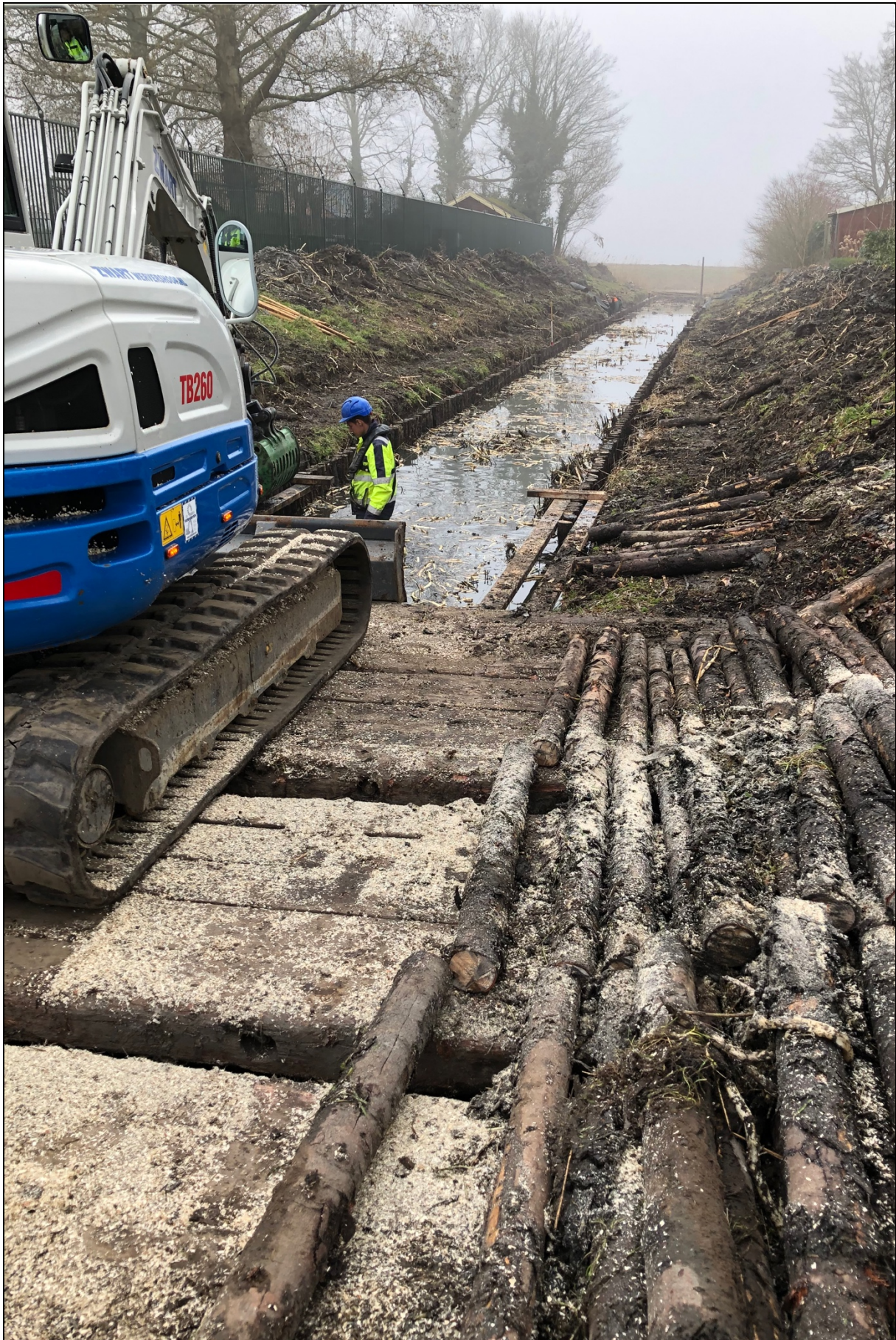
Vervangen van een beschoeiing in Wieringerwerf
