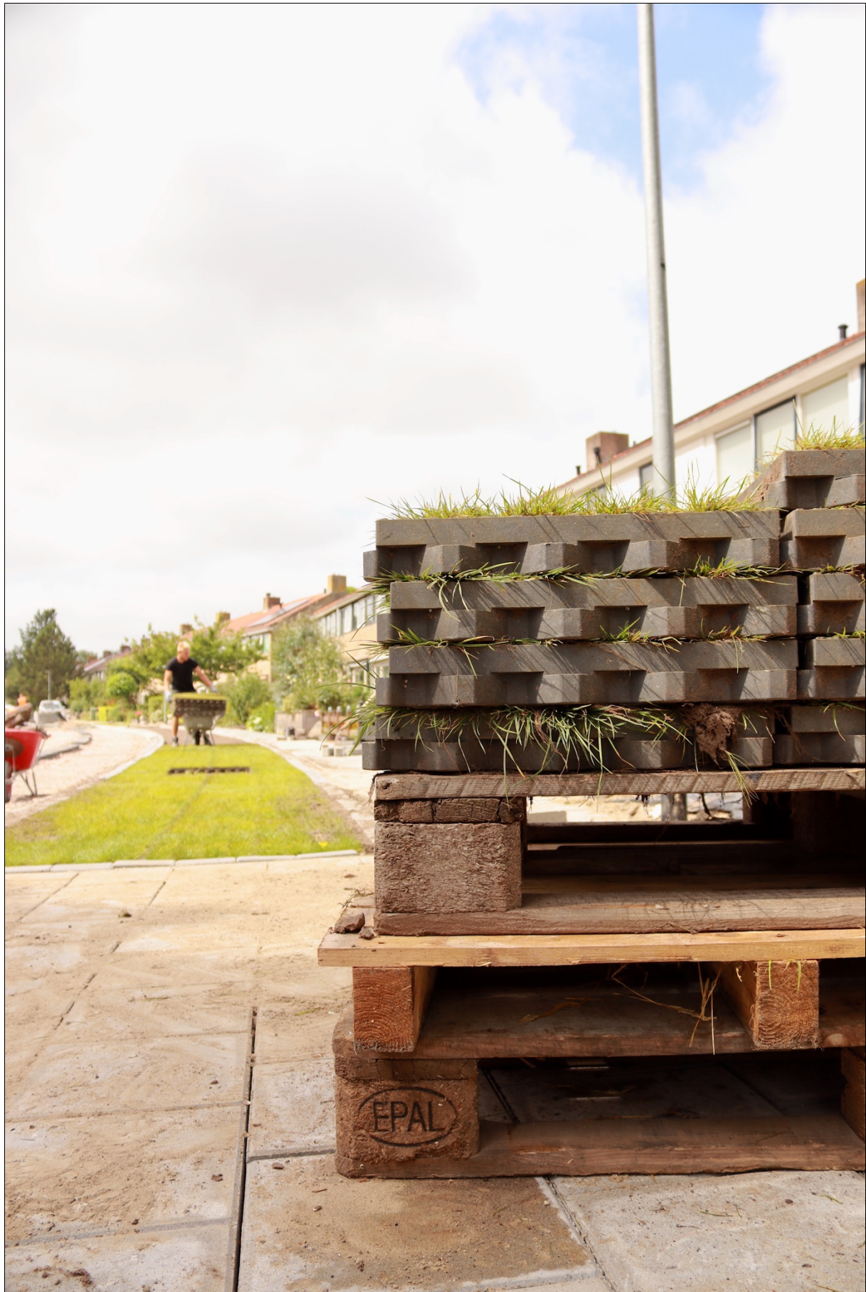
Aanleg groene parkeerplaats in Wieringerwerf
