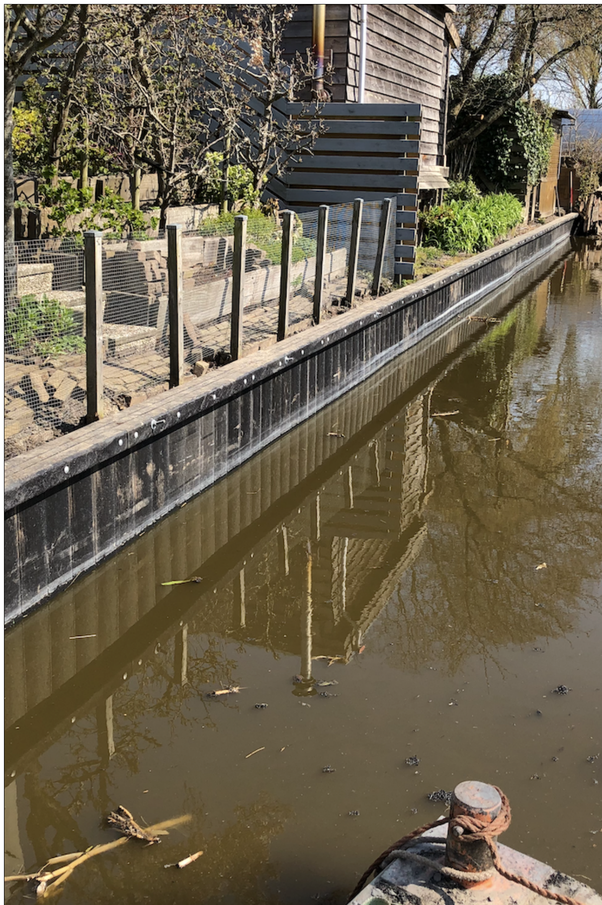
Nieuwe damwand van kunststof in Wieringerwerf
