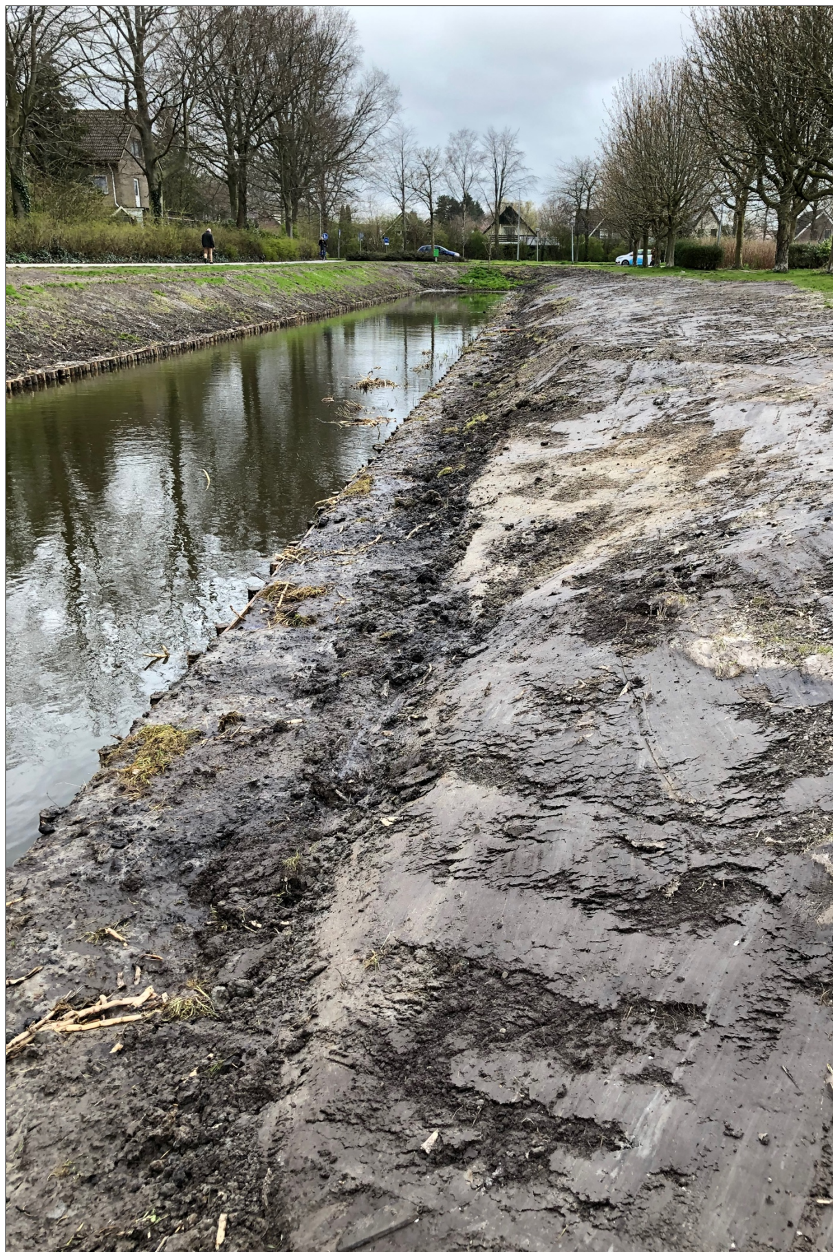
Nieuwe beschoeiing met plasberm in Wieringerwerf
